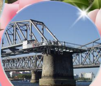
สะพานขาดตานตง
